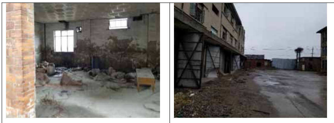
图 4.2-4 部分未拆除构筑物
