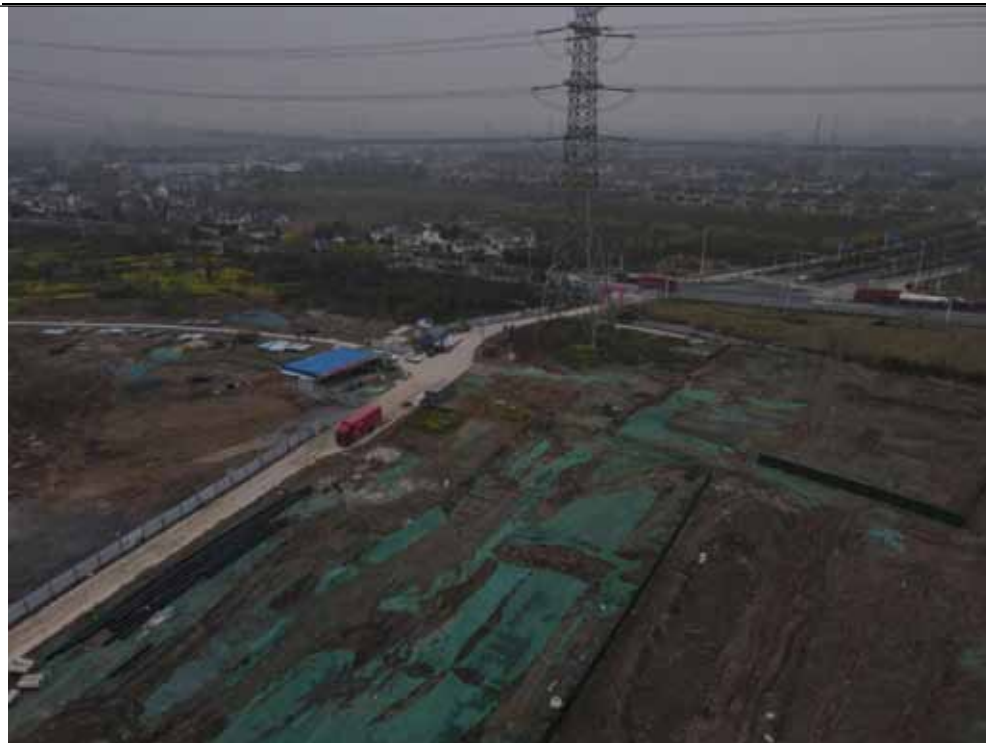
地块内北侧构筑物已拆除
