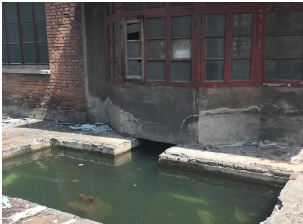
图 4.2-3 工业废水地下储存池
