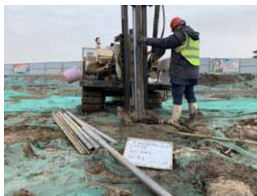
地下水采样井钻探
