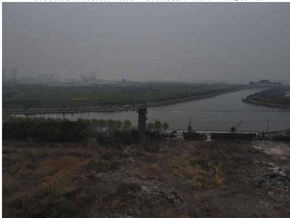
地块内大部分构筑物已拆除，残留部分矿渣
