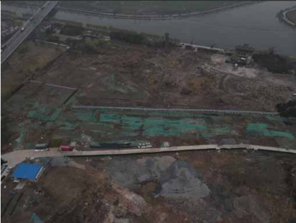
地块内中部，构筑物已拆除，未硬化地面覆盖防尘网。
