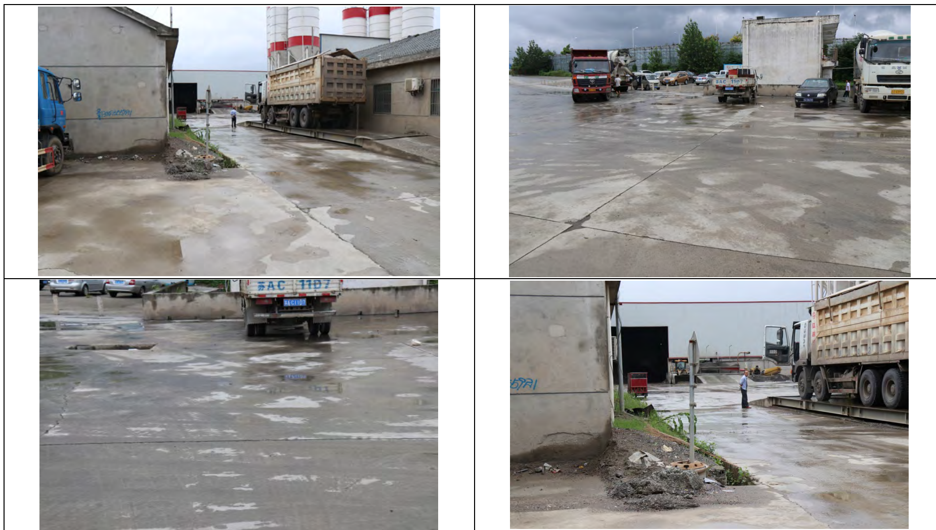
图 2.1-6 南京福荣混凝土有限责任公司现场照片（来源：顶山街道环保办工作人员 2017 年现场检查拍摄）
